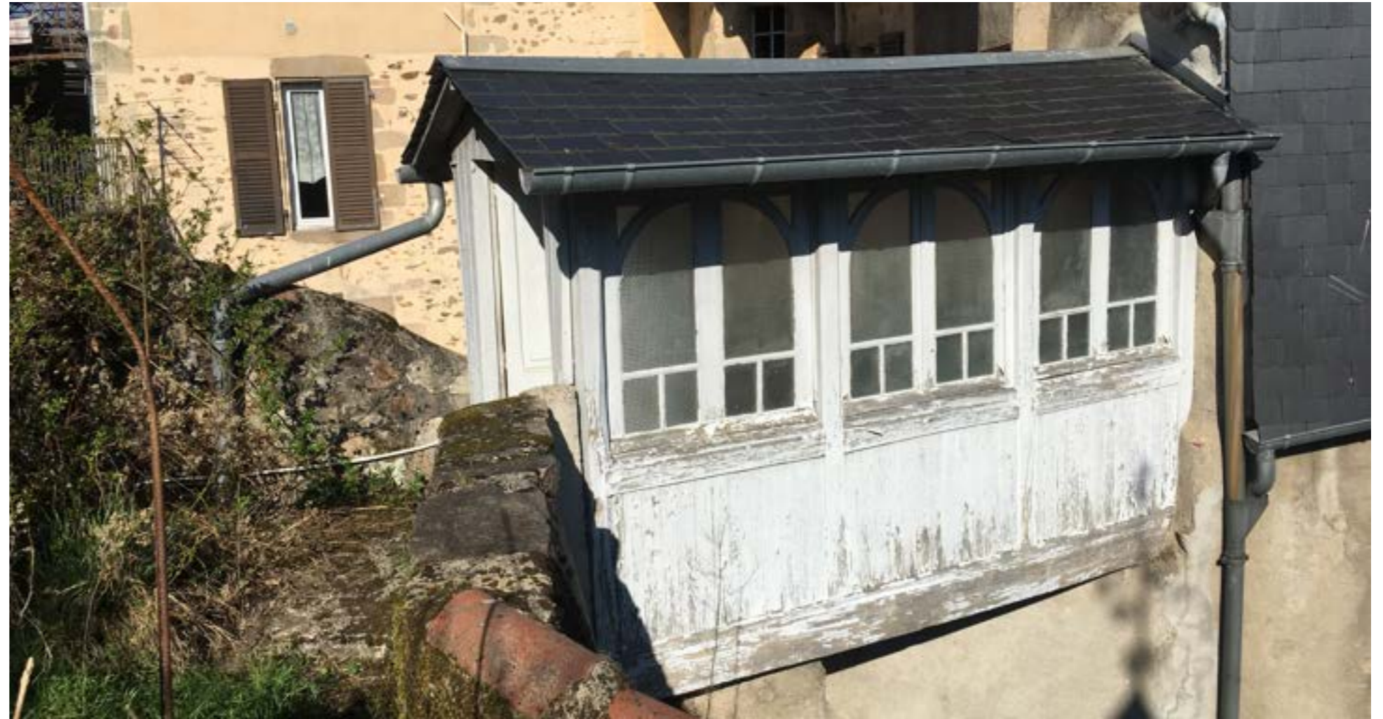
Passerelle pour accéder au jardin depuis la maison
